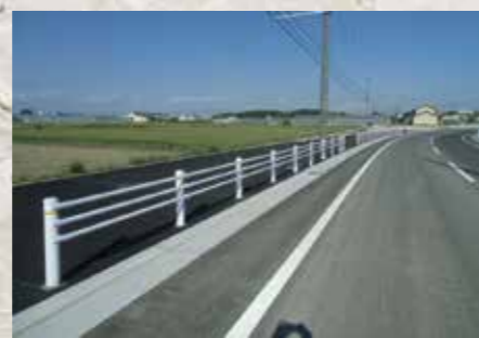
◎ガードパイプ
